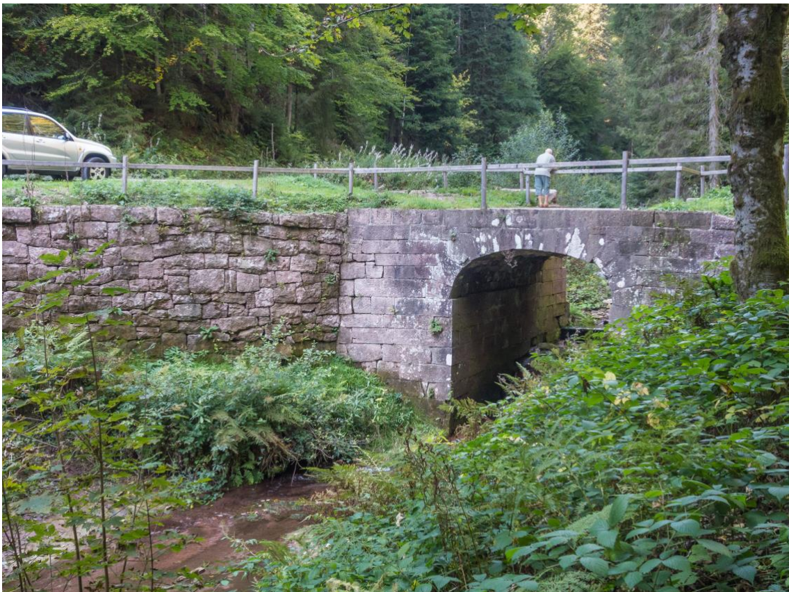
Die untere Lay-Schwallung in Hinter-Kaltbrunn
