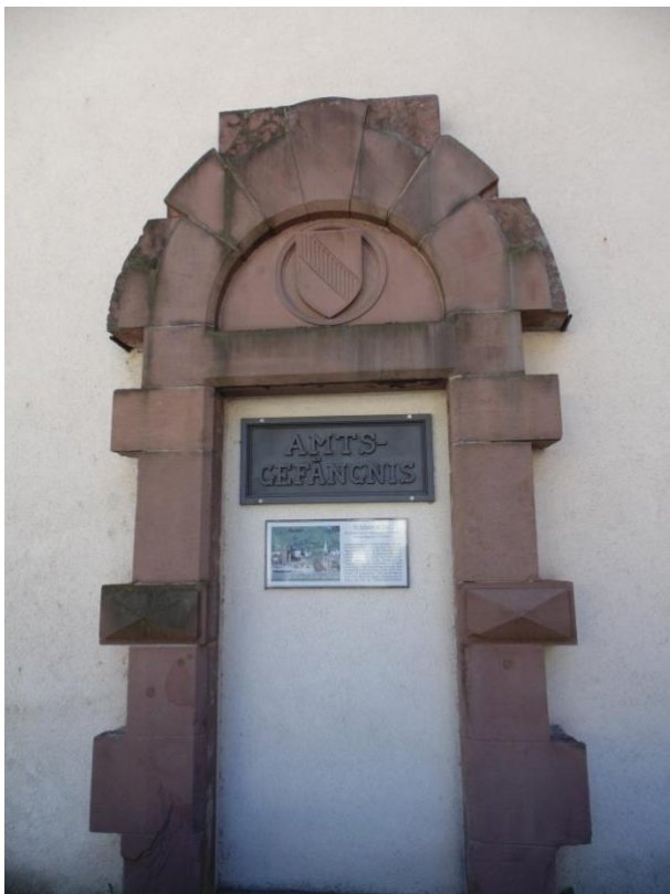
Nach dem Abriss des Wolfacher Amtsgefängnisses 1990 wurde das Turmportal an eine Wand hinter dem Rathaus versetzt. Aufnahme: Frank Schrader
