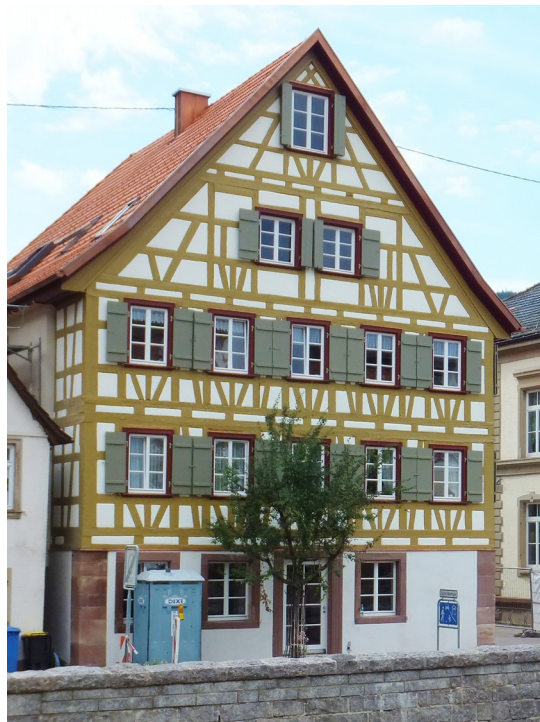
Das „Alte Schulhaus“ in der Endphase der Sanierung im Sommer 2016 Foto: R. Mahn
