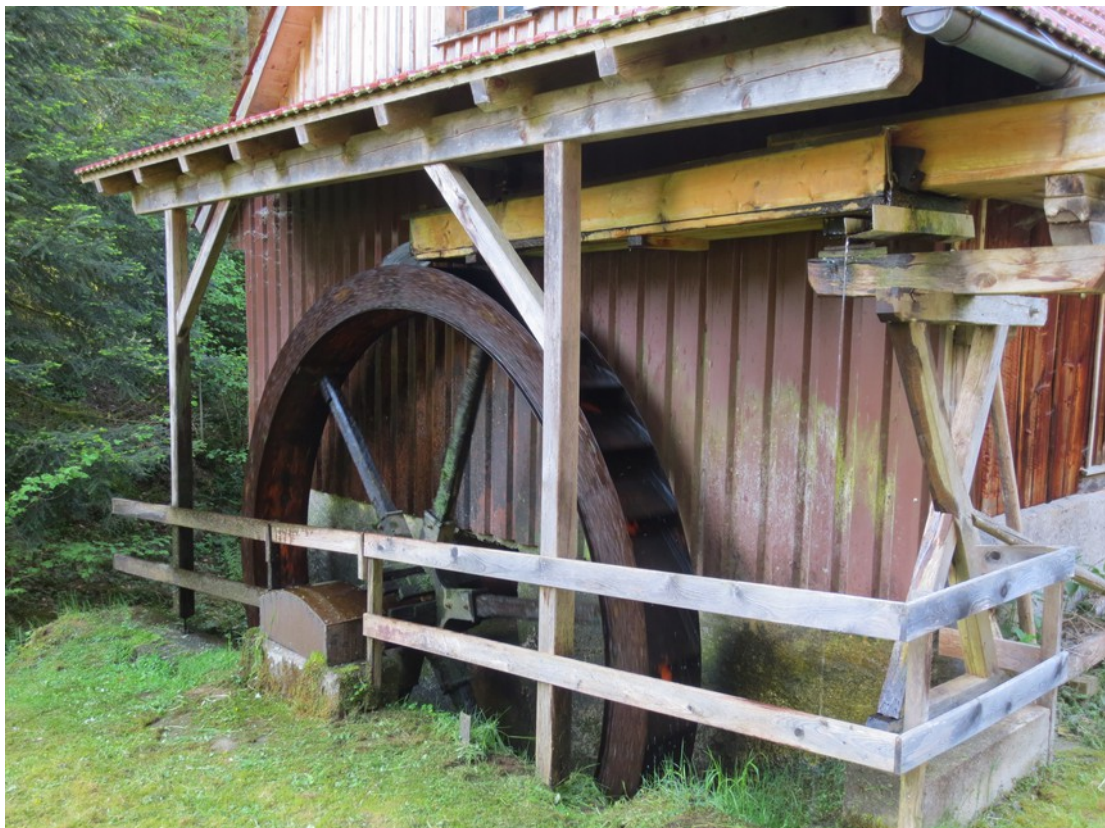
Noch betriebsbereit: Hausmühle im Lehengerichter Reichenbächle.
