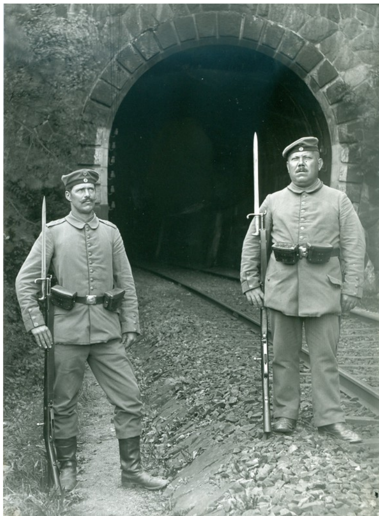
Landwehrmänner am Häberlesbergtunnel 1914, Foto: StA Schiltach
