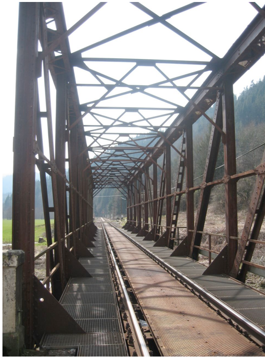
Abgebrochen, aber nicht ganz vergessen: die Bahnbrücke beim Haldenhof. - Foto: H. Harter
